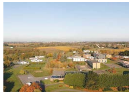
Vue aérienne Site de Vertou
